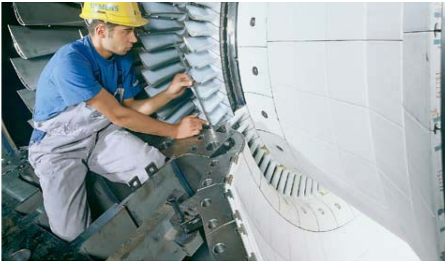
Montage einer Siemens-Gasturbine
